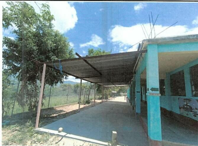
Foto1: Cambio de techo de lámina a lámina troquelada calibre 26.
