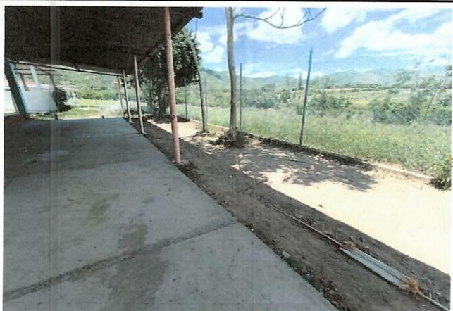
Foto 3: Losa de patio.
